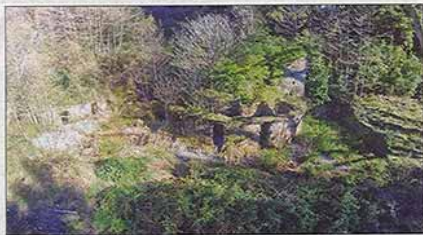
Sous les herbes et les ronces, les vestiges du site de Puzzichellu situé sur la commune d'Aghjone.
